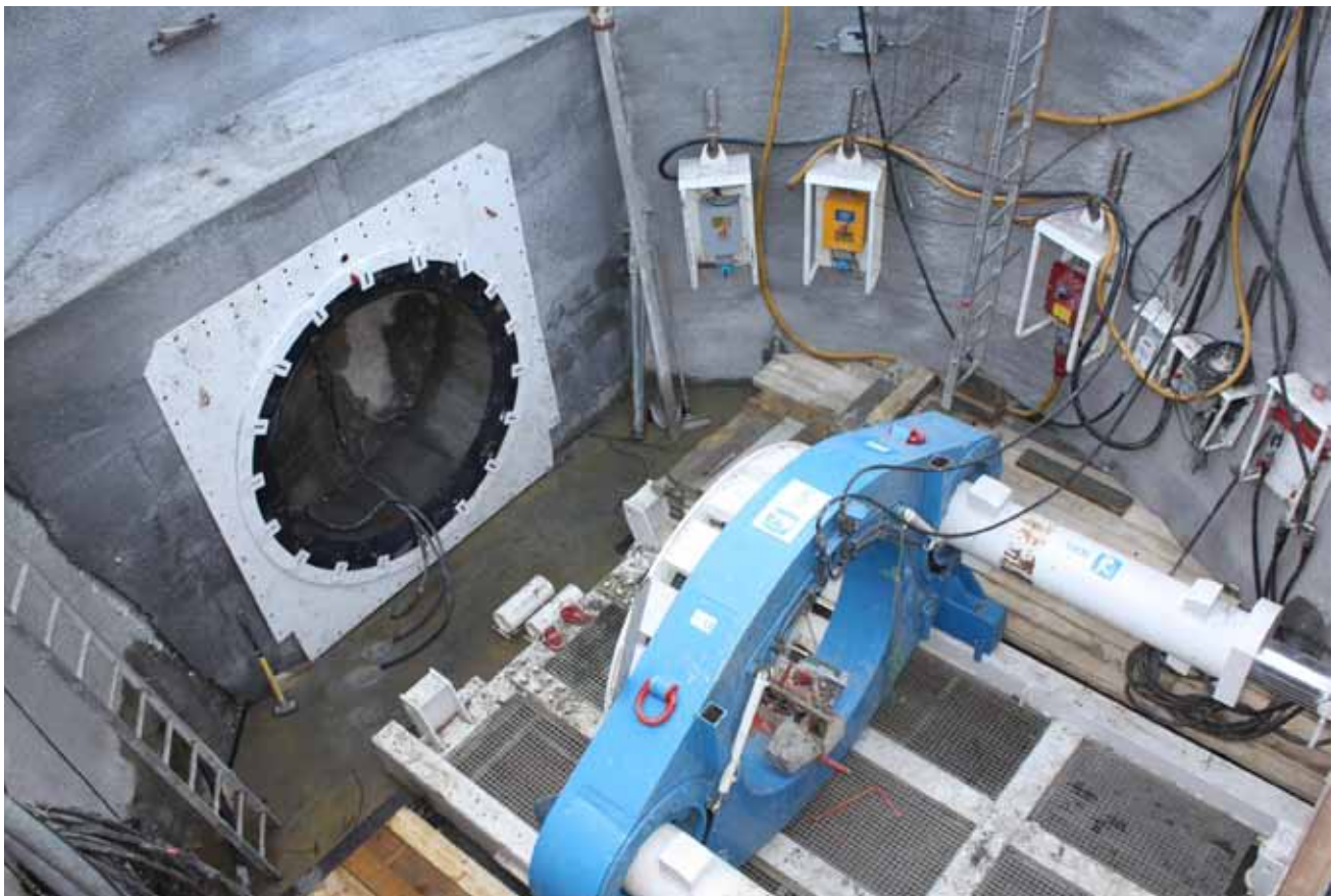
Tunnelier du collecteur de l'Yzeron à Oullins
