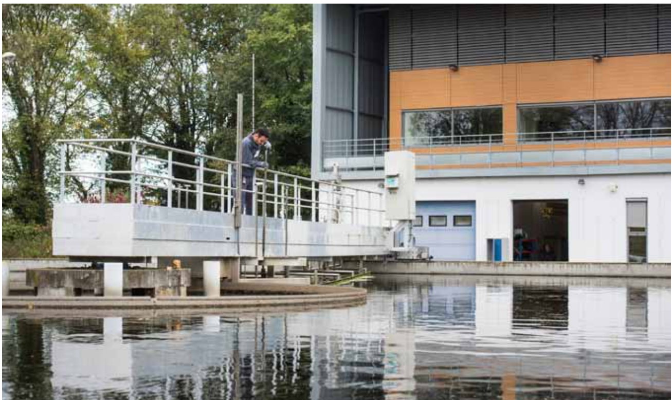
Station de traitement des eaux usées à Jonage
