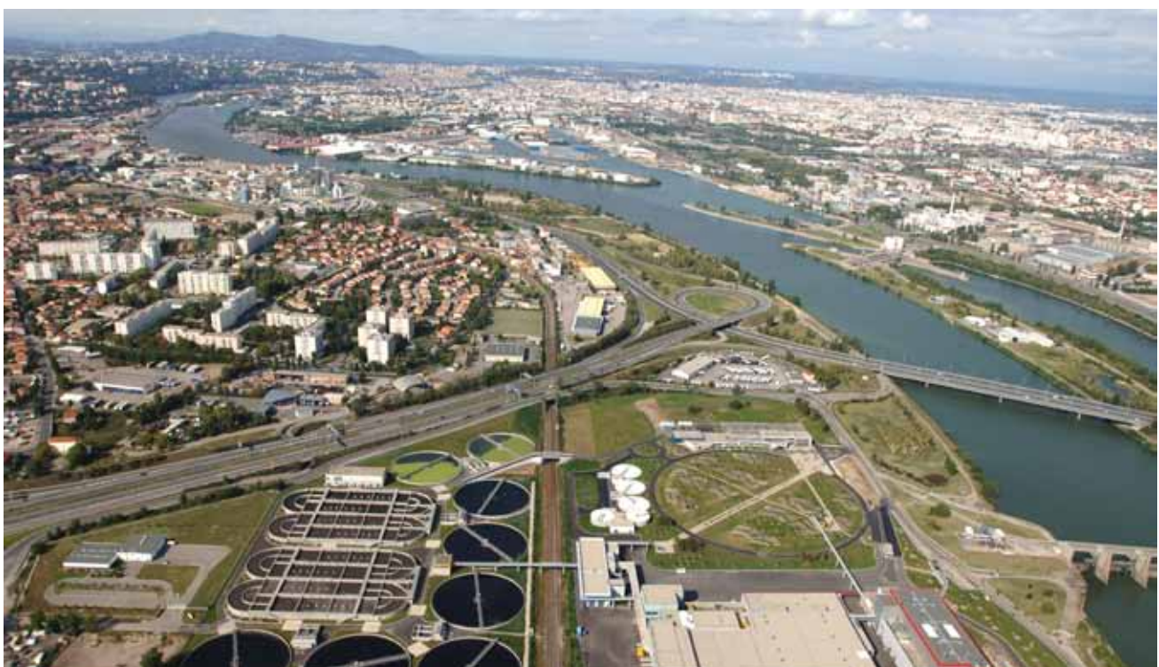
Station de traitement des eaux usées à Pierre-Bénite
