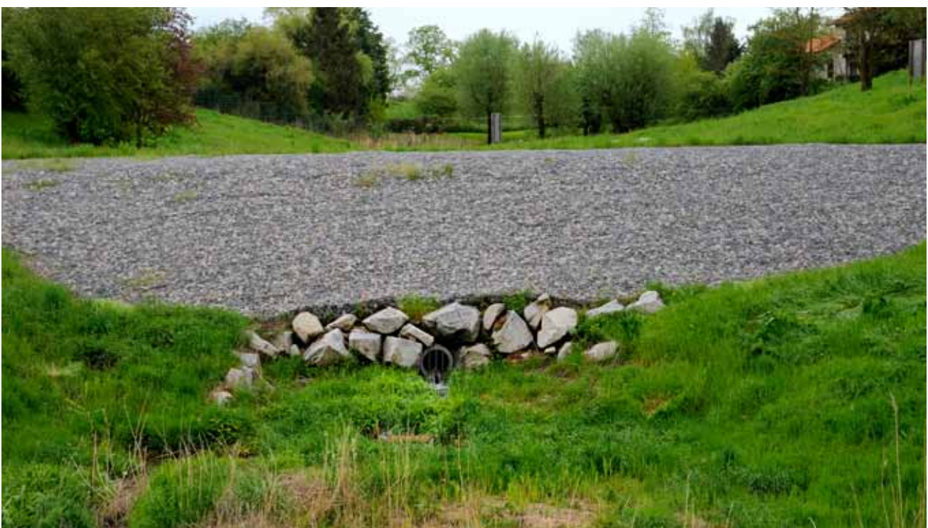
Aménagement de rétention et de traitement des eaux pluviales à Dardilly
