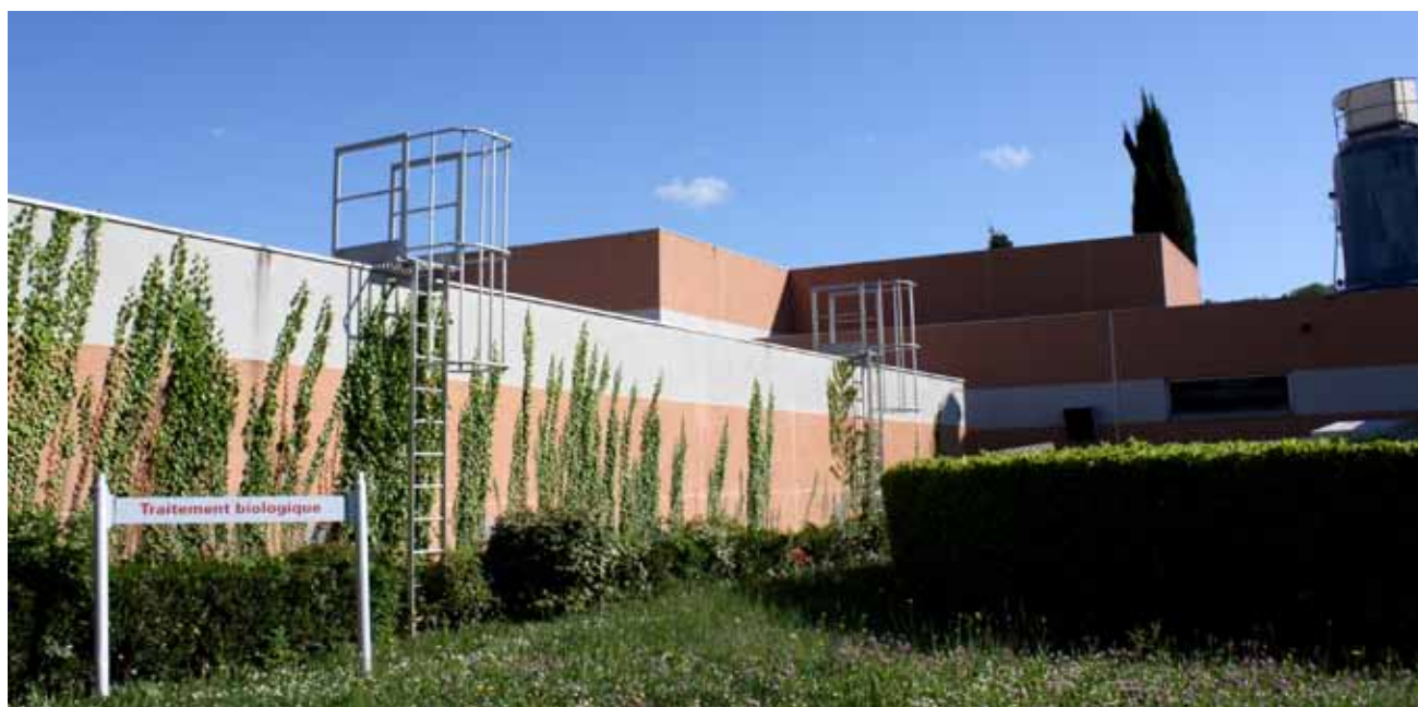
Station de traitement des eaux usées à Fontaines-sur-Saône
